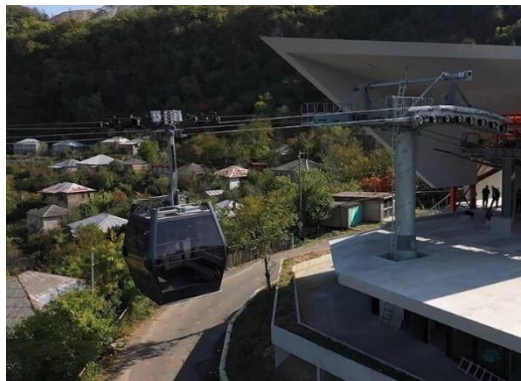
Ilustración 9. Teleférico bicable 2S reversible en Chiatura Georgia.
