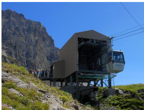
Ilustración 6. Teleférico monocable reversible de Sanetsch, Suiza.
