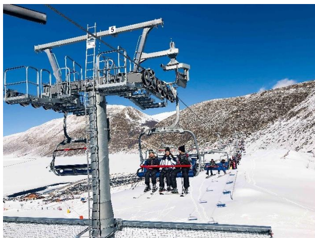
Ilustración 4. Teleférico tipo telesilla monocable unidireccional de pinza fija en Campo Felice, Italia.
