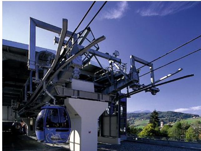
Ilustración 8. Teleférico bicable 2S unidireccional en Seis/Siusi, Italia.
