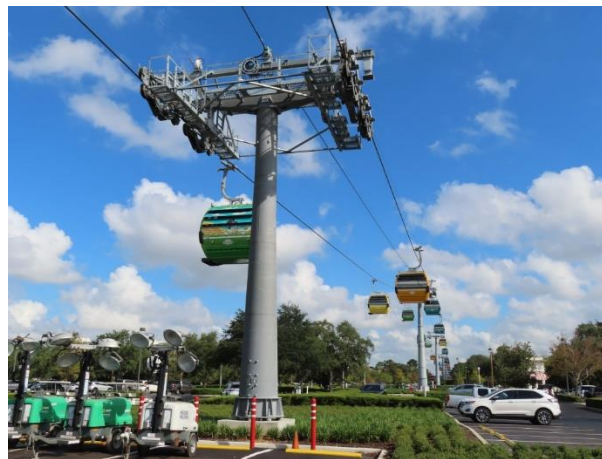
Ilustración 2. Teleférico monocable unidireccional desembragable Disney Skyliner TIG – Walt Disney World, FL, USA.
