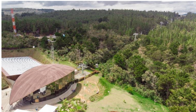
Ilustración 1. Teleférico monocable unidireccional desembragable de Arvi, Medellín, Colombia.
