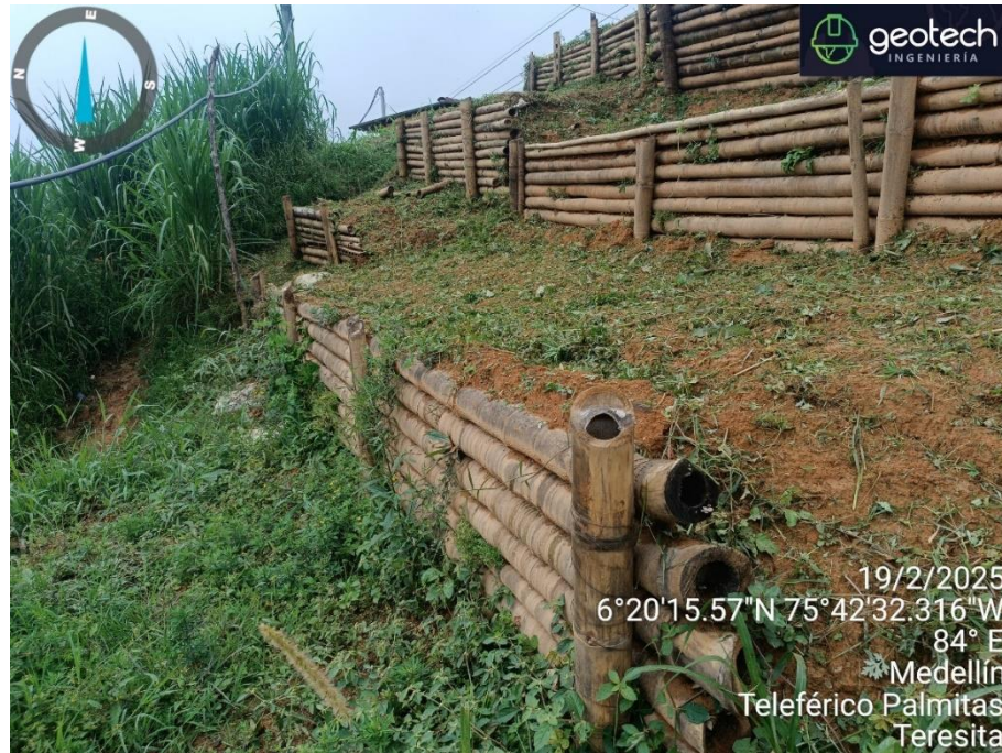
Figura 40. Movimiento en masa tratado con trinchos a 10 m al noroeste de Teresita 1. Fuente: Elaboración propia
