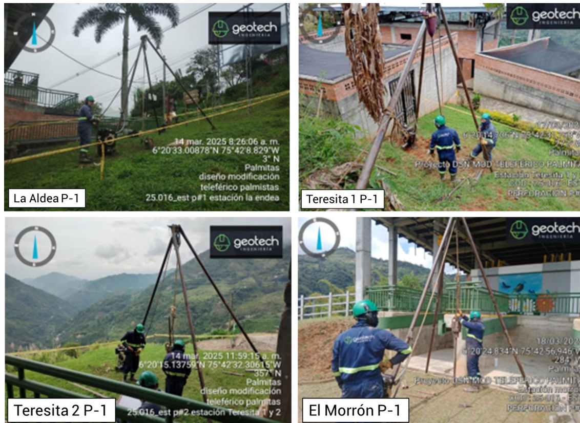
Figura 6. Registro fotográfico ejecución de sondeos Fuente: Elaboración propia
