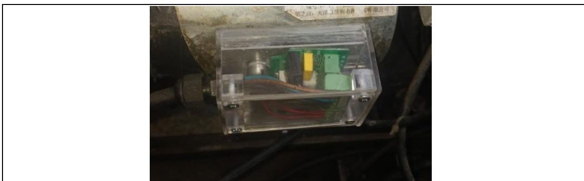
Imagen 12. Cambio de caja y tarjeta de circuitos bobina de freno.
