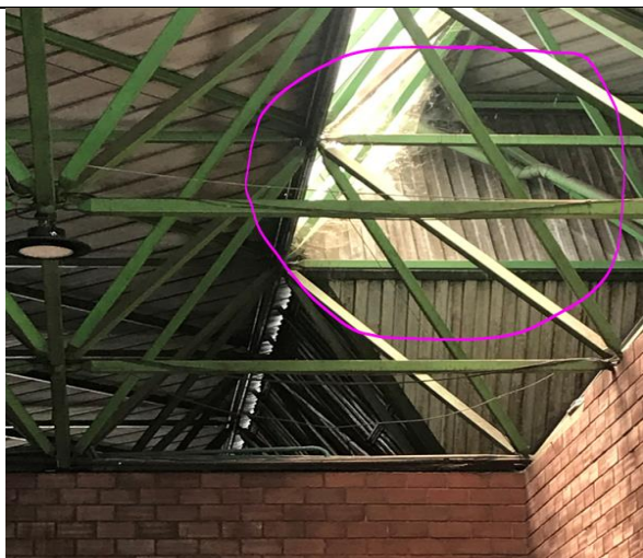
TECHOS CON HUMEDAD Y GOTERAS EN TERMINAL SUR
