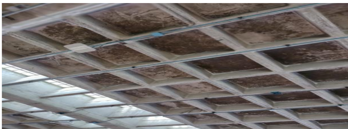
TECHOS CON HUMEDAD Y GOTERAS EN TERMINAL SUR
